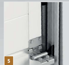
5 Układ sprężyn naciagowych
