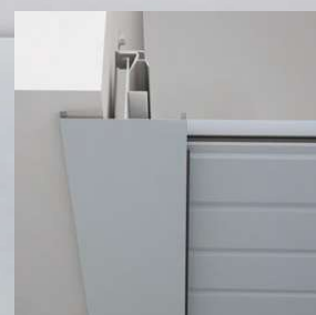
Montaż w otworze - maskownica przed otworem
